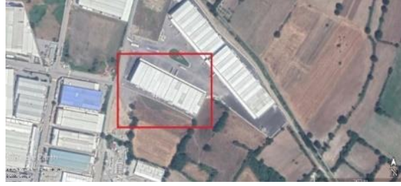
Şekil 6. Santralin Uydu Görünümü
