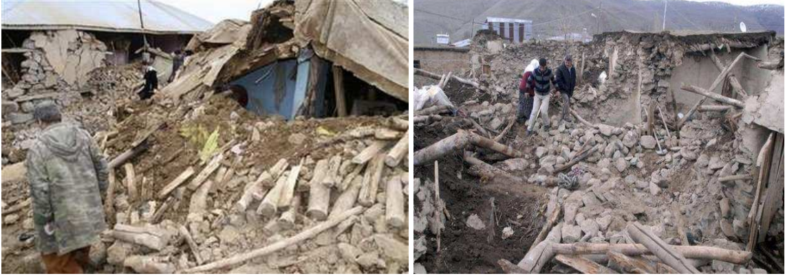
Şekil 3. Elazığ'da Yıkılan Kerpiç Evler
