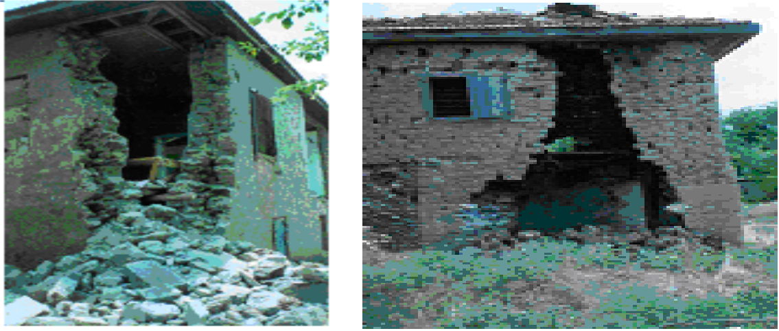
Şekil 4. Derzleri üst üste gelen ve dayanıksız geleneksel kerpiçlerle üretilen kerpiç yapılar
