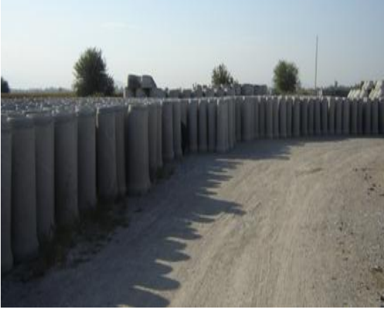
Şekil 3. Kurutma alanında bekletilen beton borular
