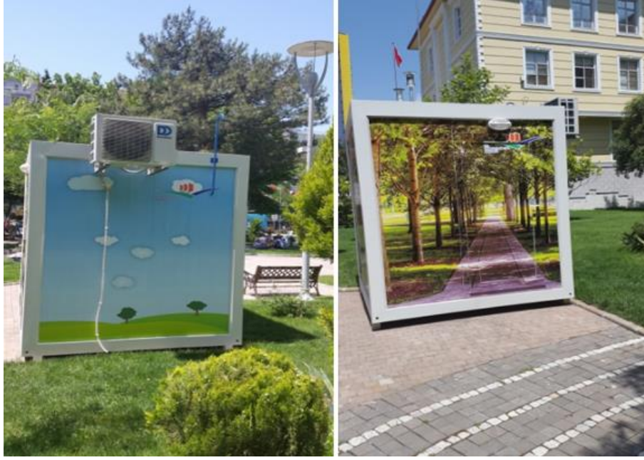
Şekil 2. Necip Fazıl Kısakürek Kültür Merkezi bahçesindeki Merkezi Hava Kalitesi İzleme İstasyonu
