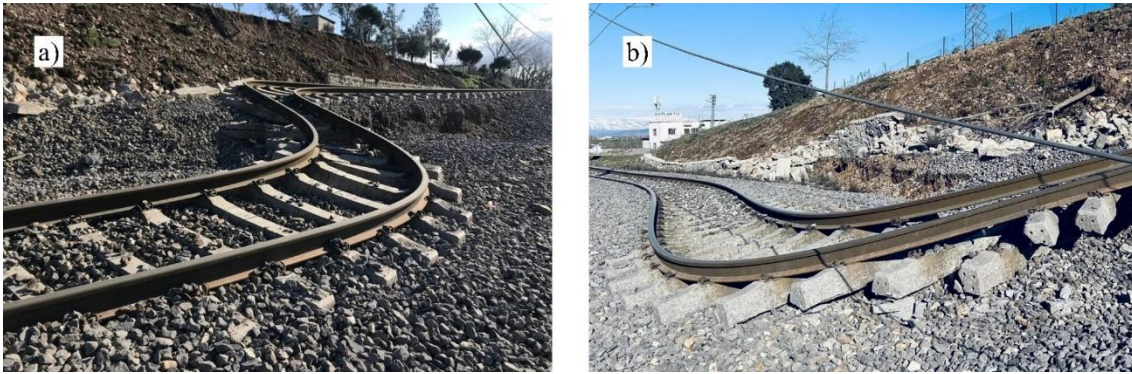
Şekil 1. Kahramanmaraş Depremi Sonrası Raylardaki Bükülme (Anadolu Ajansı, 2023)
