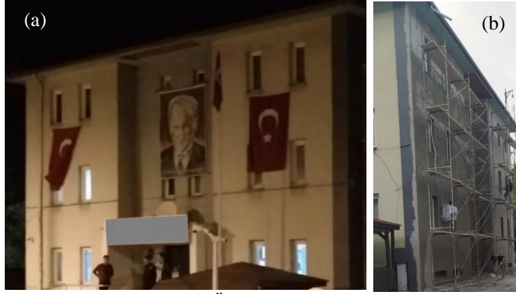
Şekil 1. İncelenen Kamu Binasının a. Yalıtımsız Ön Cephesi, b. Yalıtım Uygulaması Yapılan Sağ Yan Cephesi
