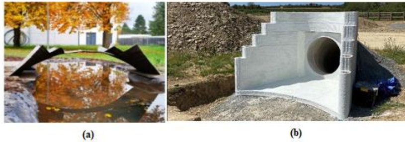
Şekil 15. a. 3B Yazdırılan Çelik Köprü (Feucht vd., 2021) b. 3B Baskı İle Üretilen Menfezli İstinat Duvarı (Cambridge Üniversitesi, t.y.).
