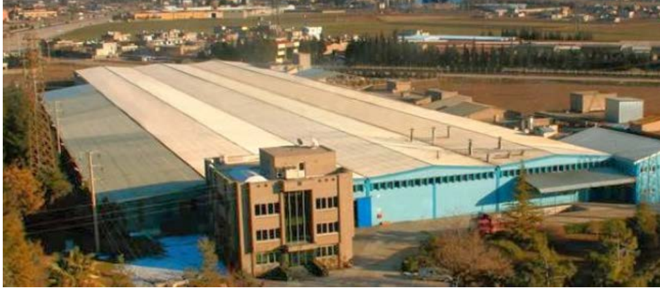
Şekil 3. Güneş panellerinin yerleştirileceği çatı
