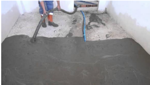
Şekil 8. Isı ve Ses Yalıtımı İçin Döşemelerde Perlitli Şap Kullanımı (Ulusal Perlit, 2023)
