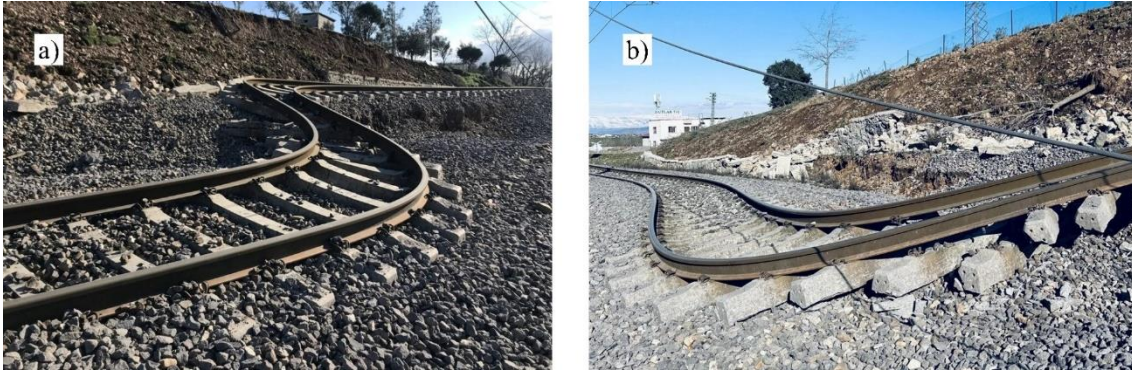
Şekil 1. Kahramanmaraş Depremi Sonrası Raylardaki Bükülme (Anadolu Ajansı, 2023)
